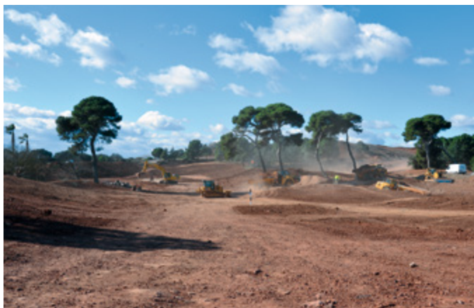
Trou n°7 en début de chantier (2013)
