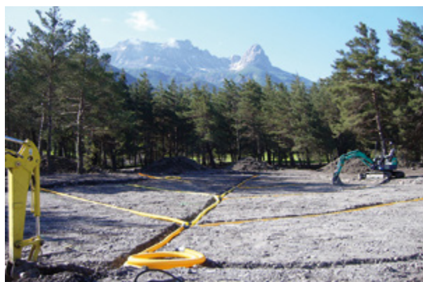
↳ Golf du Bois Chenu (04) - Pose de drainage Architecte : Hugues Lambert
